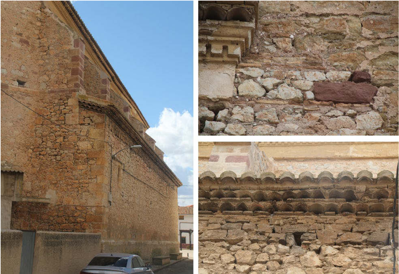
Fig. 2 (Izda.) Ángulo nordeste, donde se aprecian dos cambios de espesor en los muros y una junta de construcción
