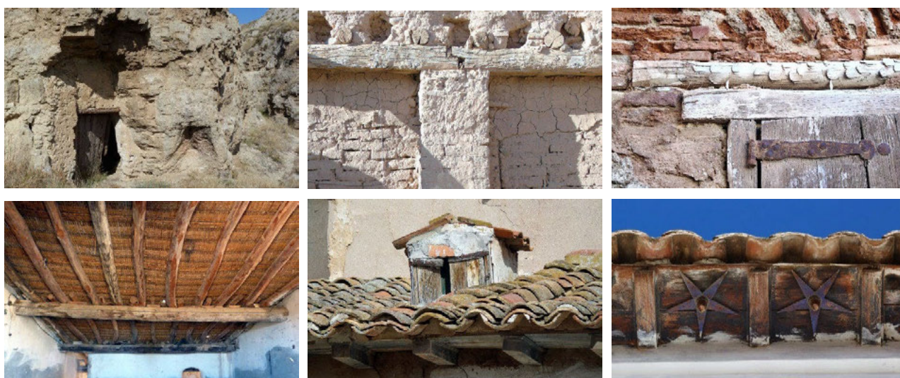
Fig. 2 Ejemplos de técnicas tradicionales de construcción identificadas
