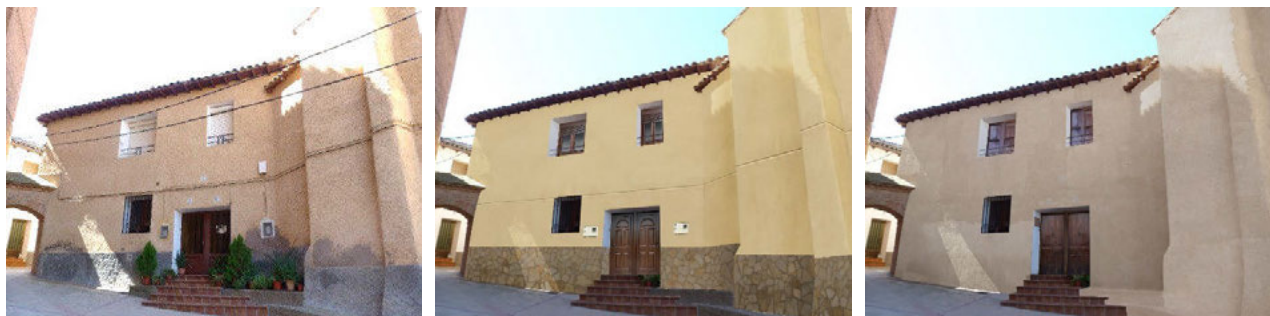
Fig. 4 Fachada de la vivienda estudiada en su estado inicial (izq.), renovado (centro) y restaurado (dcha.)
